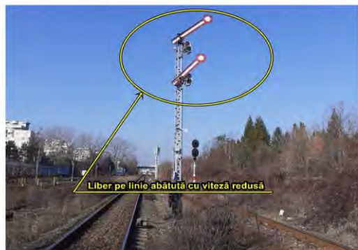
Fig. 4 Semaforul de intrare A 1/2, cap X al stației CFR Pitești din direcția Bradu de Sus
