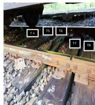
Fotografia nr. 6 - Traversile nr. 4-8 (detaliu zona de la firul exterior al curbei)
