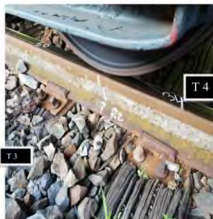
Fotografia nr. 5 - Traversile nr. 3 și 4 - (detaliu zona de la firul exterior al curbei)
