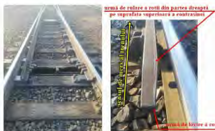
Fotografia nr. 3 - urmele lăuate pe schimbătorul de cale nr.26 de roțile deraiate
