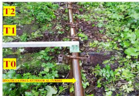
Fotografia nr. 2 - Detaliu privind starea neconformă a prinderilor plăcilor metalice de traverse T0, T1 și T2, în zona punctului „0”, la șina de la firul exterior al curbei.
